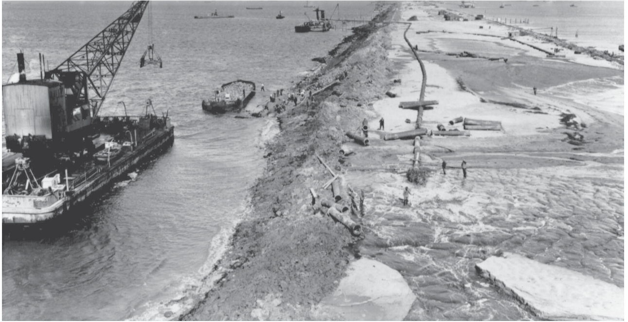
4. In september 1931 waren de werken aan de Afsluitdijk ver gevorderd. Om echter niet te grote winterschade op te lopen, werd dat najaar tot in december doorgewerkt (Foto: Rijkswaterstaat, Lelystad).
