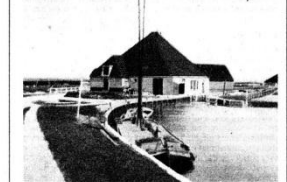
Zeswielen met sluiswachterswoning en sluis, gezien vanaf de oever. Achter de sluiswachterswoning bevindt zich de overtroom. FOTO REGIONAAL ARCHIEF
